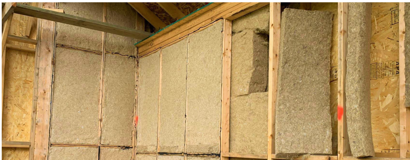
Photo 1. Panneau isolant Profib™ Mat installé
